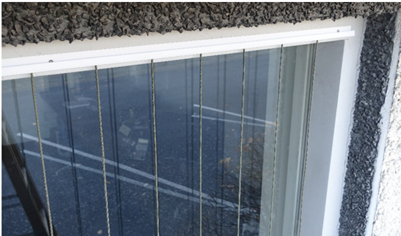
Obr. 4: Instalované Acopian BirdSavers s využitím plastového U-profilu. Vedle přivrtání lze lištu i přilepit pomocí oboustranné lepenky. Fotografie použita se svolením Jeffa Acopiana, www.birdsavers.com .
